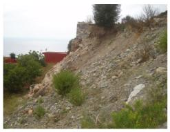
Foto 1.- Ladera con desplome del muro de contención.
