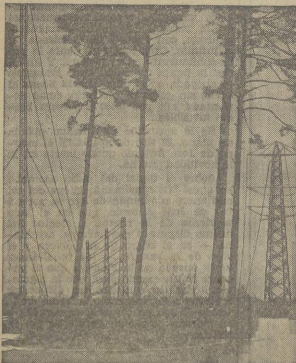
Vista del campo de la Estación emisora mundial de Zeeven. A la izquierda, una torre de antena para la Emisora Alemana, en el centro, la antena de ondas dirigidas a Africa, y a la derecha, la antena de ondas circulares para Europa.
