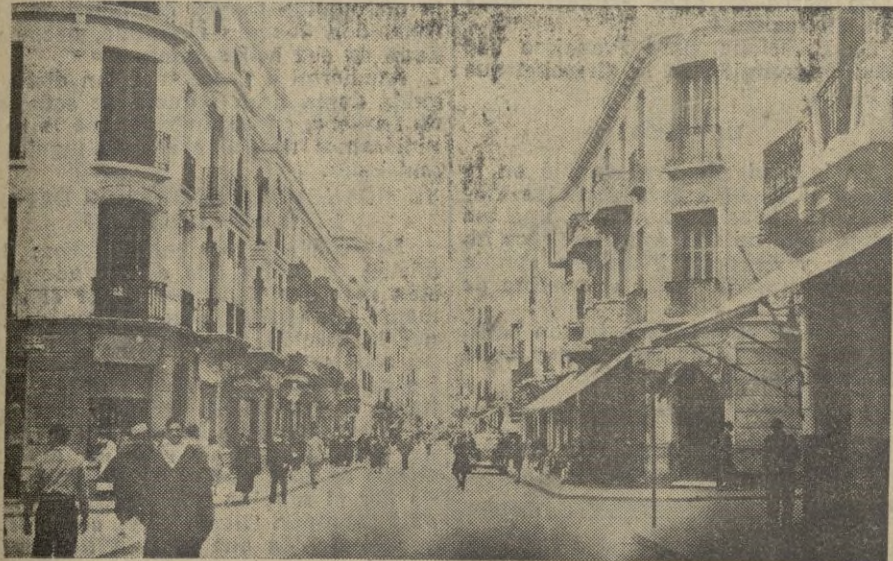
Avenida del Generalísimo, arteria principal de la moderna Tetuán.
