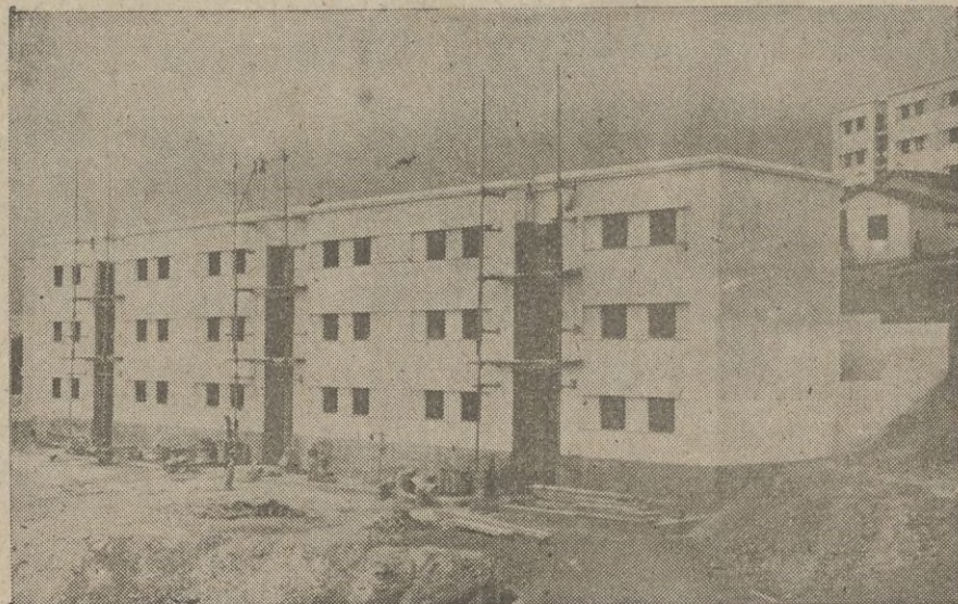
Uno de los grupos en construcción.
