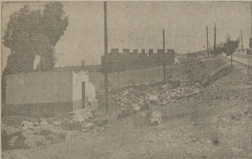
Las obras para su construcción, han sido comenzadas.
