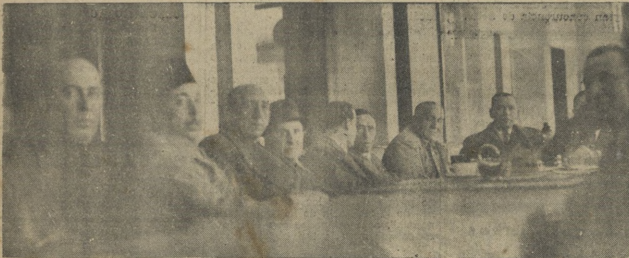
Autoridades y personas destacadas que asistieron al acto de iniciar el derribo de las casas números 1 y 3 de la calle Camoens.
