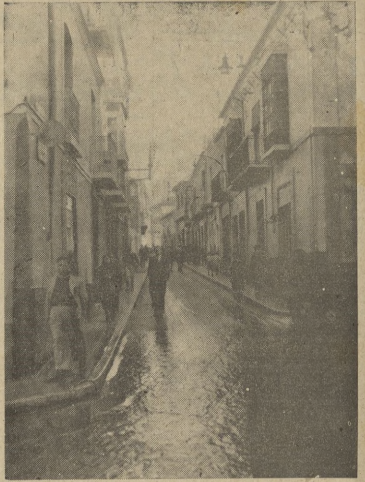
La calle Camoens antes de empezar el derribo de las casas n.º 1 y 3
