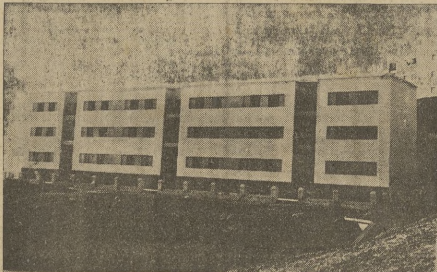
Vista general del grupo de tres bloques, con veintiuna viviendas
