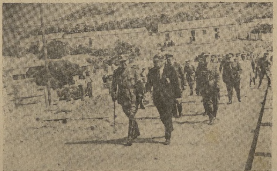
El Jefe Superior de las Fuerzas Militares de Marruecos y el Sr. Gaytán de Ayala, Ingeniero de Obras Públicas, inspeccionando la carretera en construcción. (Fotos: Perea)
