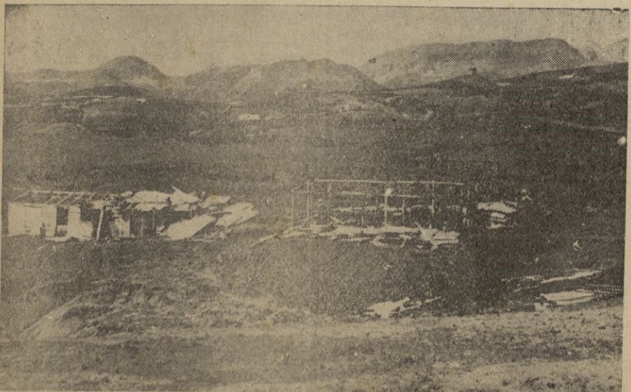
En plena actividad, situando varias barracas
