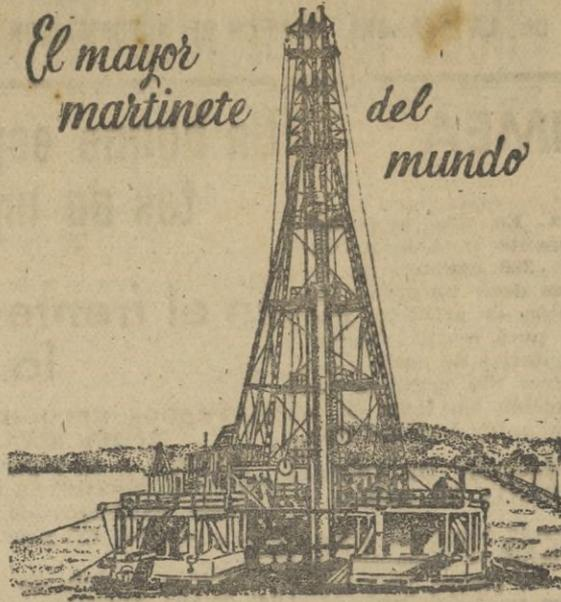
fué utilizado por GRUEN & BILFINGER A. G. de Mannheim en la construcción del puente de Lidingö cerca de Estocolmo sobre un estrecho de 750 m. de ancho. El martinete colocó en el fondo del mar postes de cemento armado de 40 m. de largo y 1 m. de diámetro.
