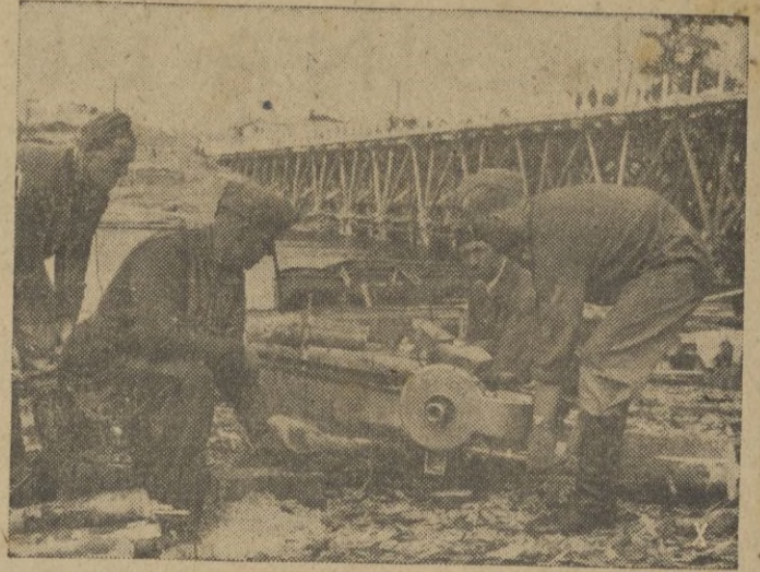
5.500 pinos se emplearon para el gran puente construido cerca de Smolensko sobre el Dnepr. He aquí un grupo de pontoneros alemanes trabajando con la sierra de motor.
