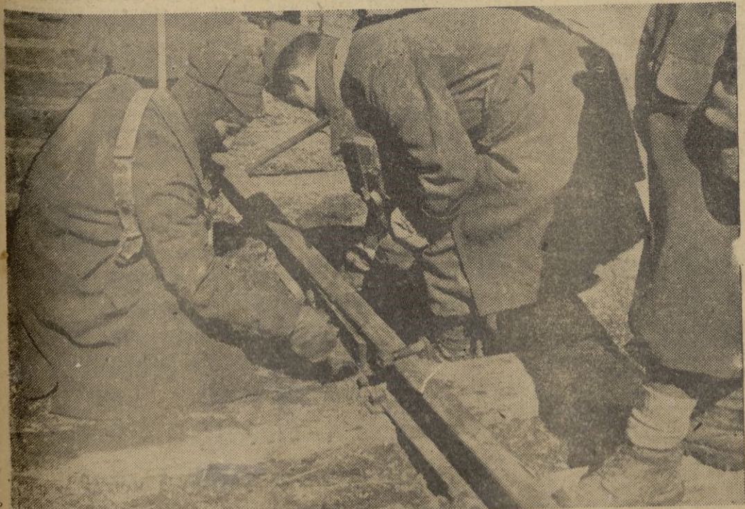
FRENTE RUSO: Soldados de ingenieros italianos arreglando las líneas ferroviarias.
