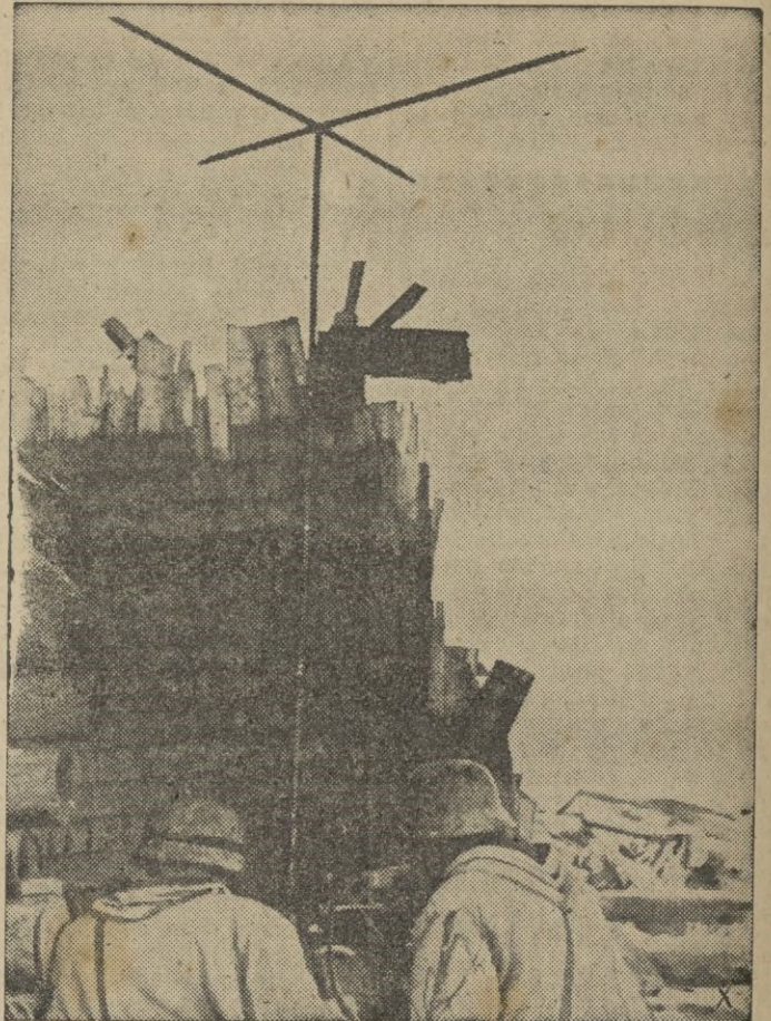
Las ruinas de una casa derrumbada sirven de protección para una centralilla de transmisiones.
