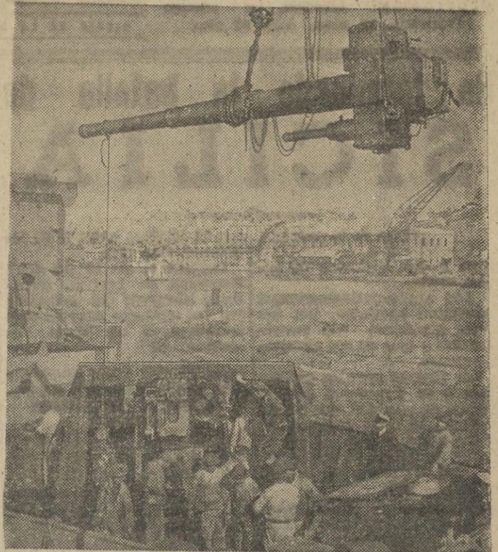
Sebr: un destructor británico fondeado en Malta es montado un cañón de 4 pulgadas, para sustituir a otro deteriorado al disparar contra la aviación enemiga que había atacado a un convoy inglés.
