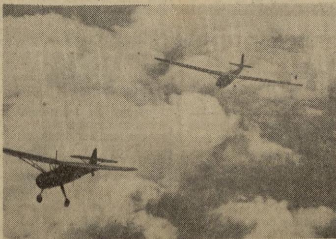
Un aparato alemán remolca por medio de un sólido cable, a un avión de carga, dirigido por una vela.
