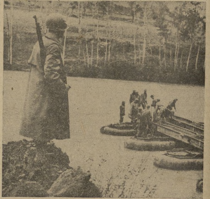
Ingenieros americanos tendiendo un puente en el frente italiano en tanto que un centínela monta la guardia.
