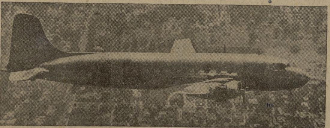
El avión norteamericano de transporte «DC-4», que se está fabricando en serie para usos comerciales, puede transportar quince toneladas de carga a una velocidad de 375 kilómetros por hora.
