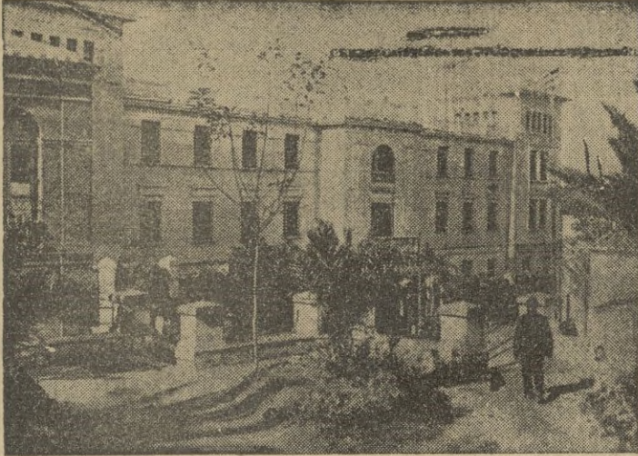
Vista parcial del Colegio.
