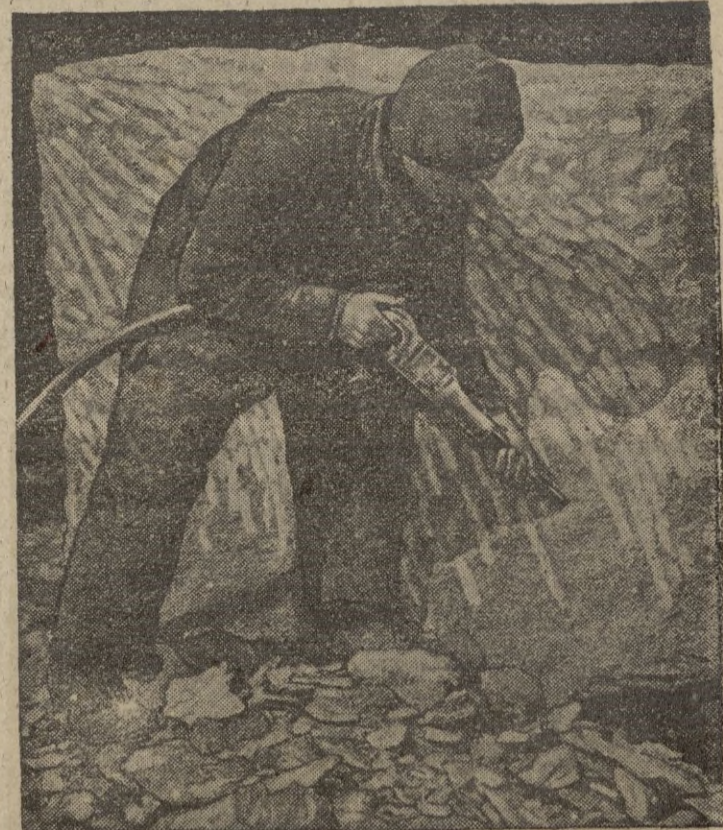
Ha dado comienzo la construcción de la nueva Cámara de los Comunes, cuyas obras costarán un millón de libras y tardarán tres años. Se emplearán roble inglés y piedra Clipsham, la más resistente a la acción del tiempo. Véase en la foto la preparación de un bloque de piedra antes de su transporte a Londres.—Calpe)
