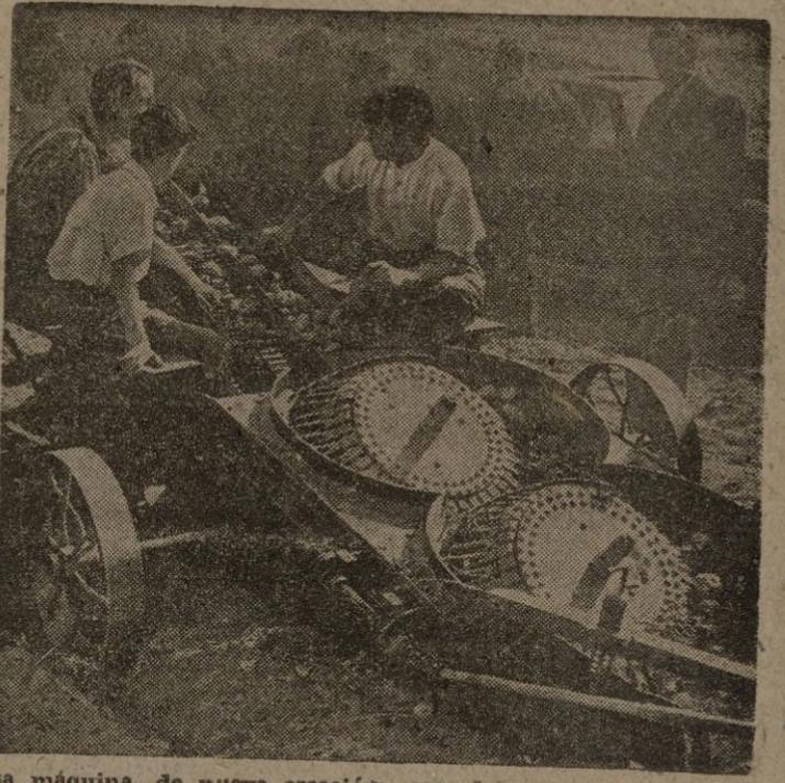
Esa máquina, de nueva creación, saca las patatas de la tierra y las mete en los sacos. Consta de dos partes: una que recoge dichos tubérculos del suelo y la otra que los clasifica y los coloca en los sacos o en el remolque.—(Galpe).
