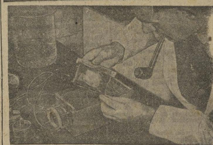
Ya se ha logrado el lavado de materiales mediante la vibración supersónica de alta frecuencia, prescindiendo del jabón y el agua hirviendo. En este aparato de Mr. Bold, el material se sumerge y por medio de un reproductor de cuarzo se le aplican vibraciones supersónicas. En menos de diez minutos se consigue una total limpieza. En la foto primera, Mr. Bold en el amplificador regulando la frecuencia y en la otra muestra el trozo de material que acaba de ser sometido a "tratamiento".—(Calpe)
