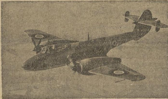
El «Gran Meteor», fué el primer avión accionado con turbina de gas y es en la actualidad el único de este tipo que funciona satisfactoriamente con este procedimiento. El modelo ha completado 80 horas de vuelo a todo el rendimiento de sus motores.—(Calpe)
