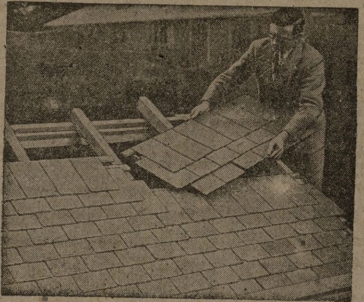
Los británicos intensifican la construcción de nuevas casas para hacer frente a la crisis. He aquí un ensamblaje previo de pizarras antes de proceder a la edificación definitiva.—(Galpe).
