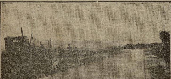
Extendido de aglomerado asfáltico después de haberse ensanchado la carretera
