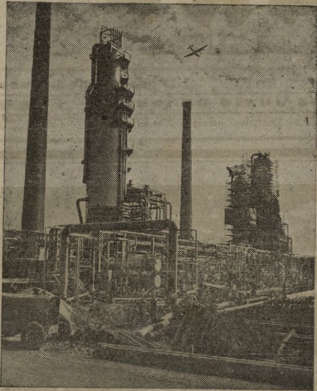
La mayor refinería de petróleo de Europa, actualmente en construcción en Fawley (Inglaterra) que se espera quedara terminada para fines del presente año
