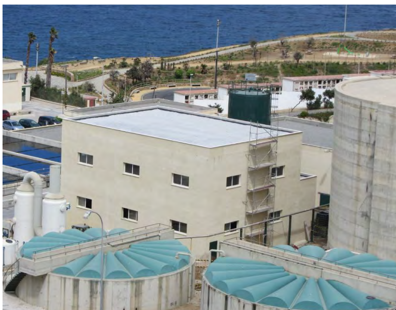
Figura 30. Edificio desodorizado en construcción para el secado de fangos.
