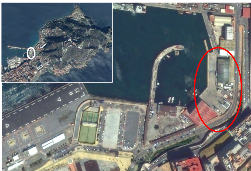
Figura 20. Instalaciones de ECOCEUTA en el Muelle de Alfau
